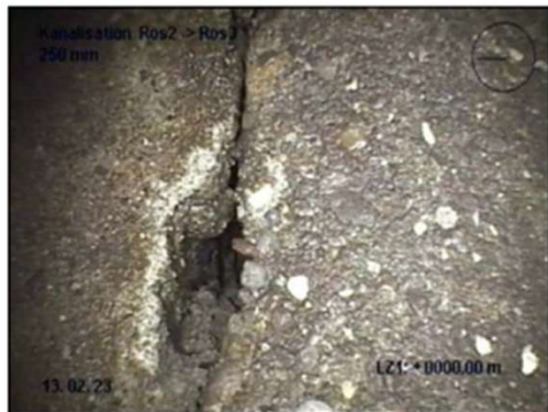
0.00 m Foto 1 Fehlende Scherbe / Wandungsteil an der Rohrverbindung 9 Uhr, Übergang zu Schach
